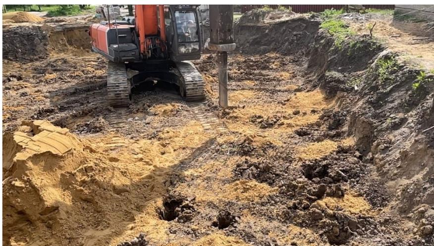
Рис. 1. Выштамповка микросвай на строительном объекте
