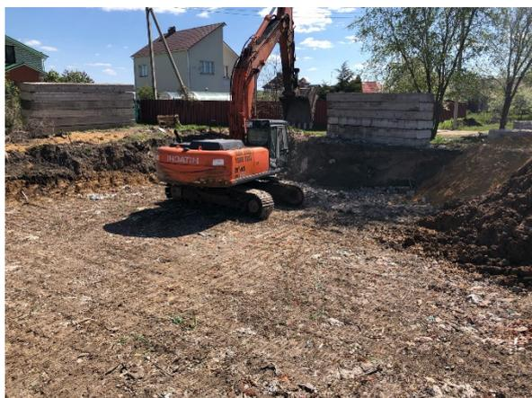
Рис. 1. Уплотнение смеси глины и кальциевого строительного мусора на объекте
