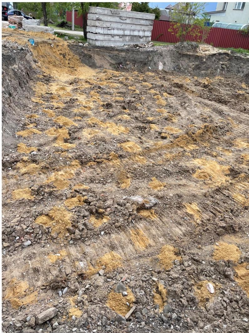
Рис. 2. Заполнение микросвай песком
